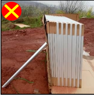
图 8.4-2 组件倚靠方式错误 Wrong way of leaning modules
